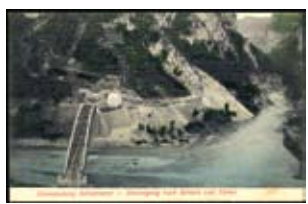
1015 Željeznički most, 16 granica sa Srbijom oko 1910. #/A
