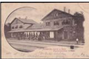
2850 Dalj 1900. 16 Željeznička stanica. #/A-B
