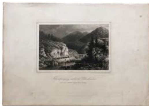
1094 CELJE-LJUBLJANA PRUGA, veduta. Trst, 1860. "Felsensprengung nächst der Bleischmelze (auf d. K.K. Südbahn zwischen Cilli u. Laibach)". 30,5x21,5 cm. Stanje odlično.
